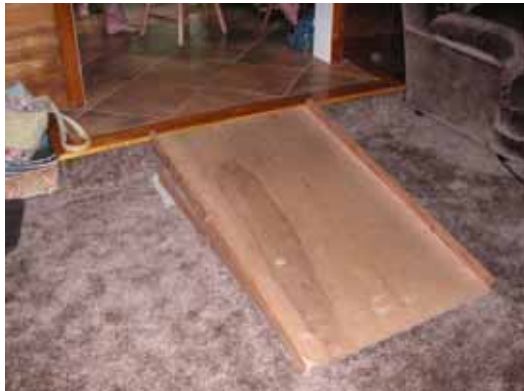
写真：簡単な木の板のスロープ
